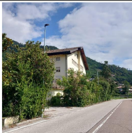
Vista a valle, da SP228
